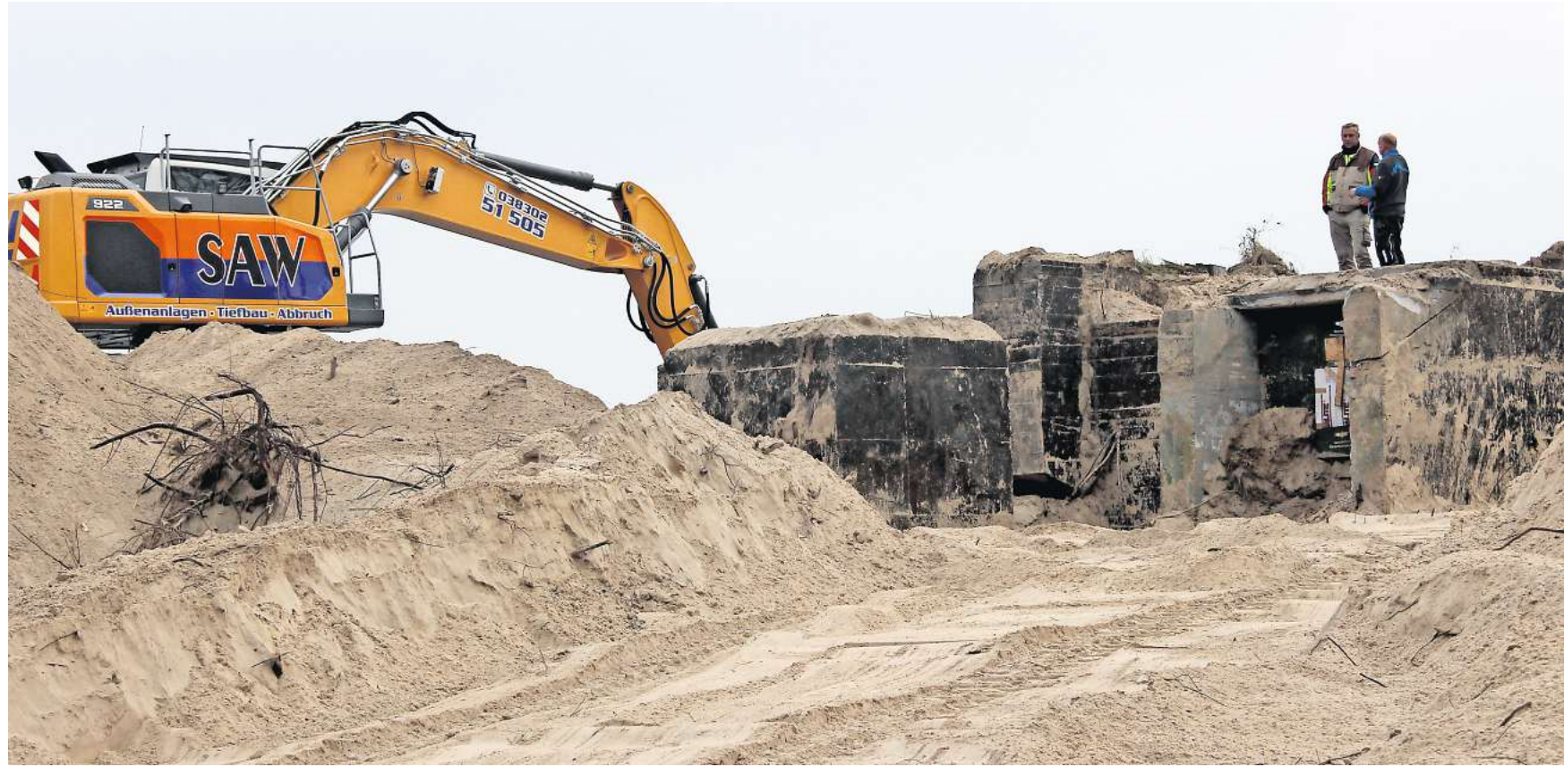
Vor dem Abriss wird der Bunker freigeschaufelt.
