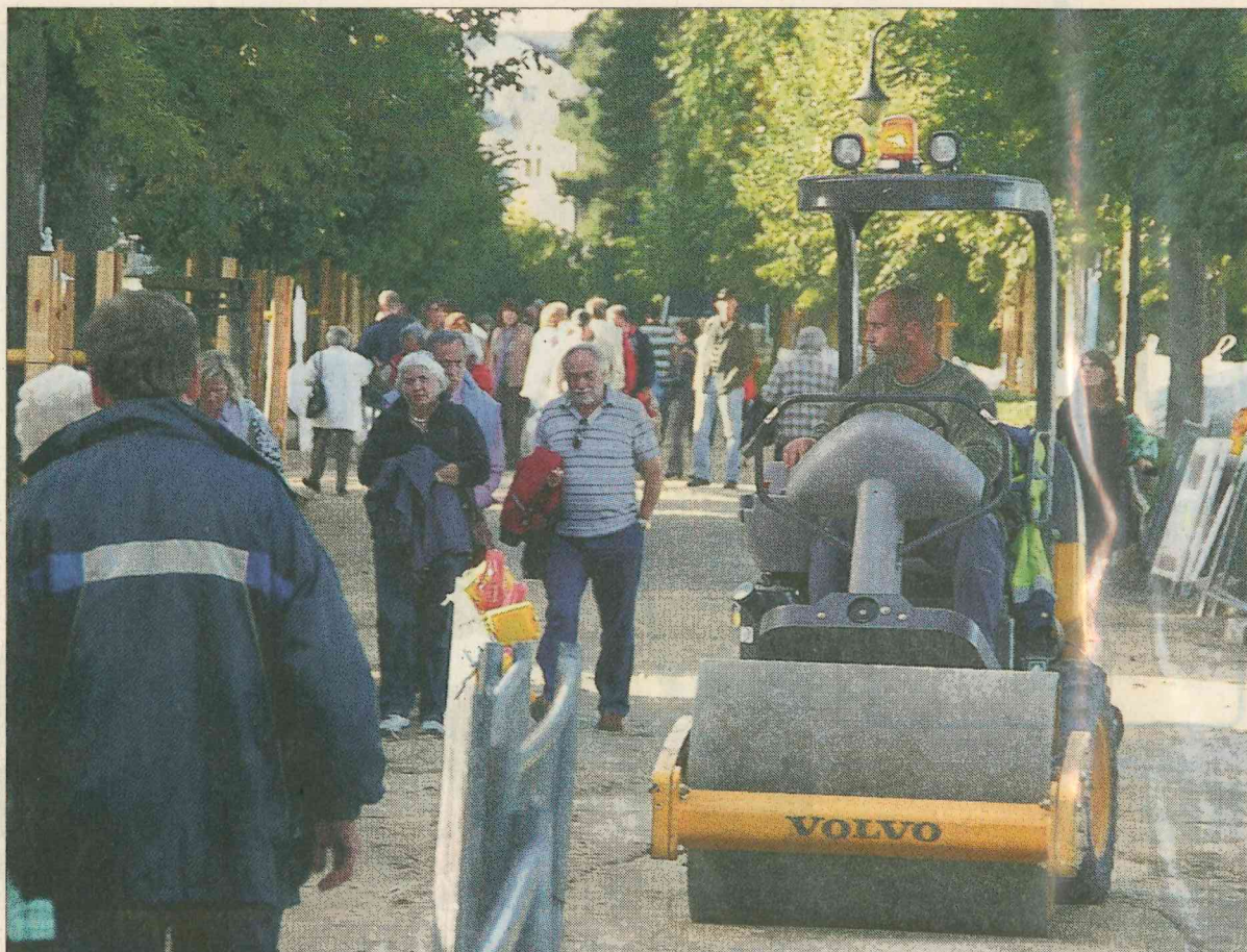
Auf dem nördlichen Abschnitt der Binzer Promenade tummeln sich derzeit Spaziergänger und Bauarbeiter. Foto: Meyer
