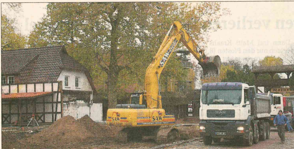
Baggern im Akkord. Mitarbeiter der Sagarder Abbruchfirma SAW führen zurzeit die Erdarbeiten für das neue Mehrzweck-
